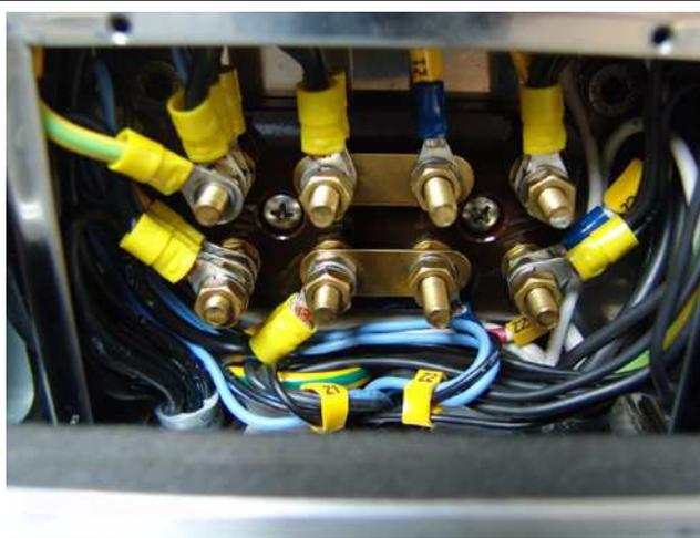
Fig. 3.3.6-13: Caja terminal de potencia del generador de 120 voltios/60 Hz
