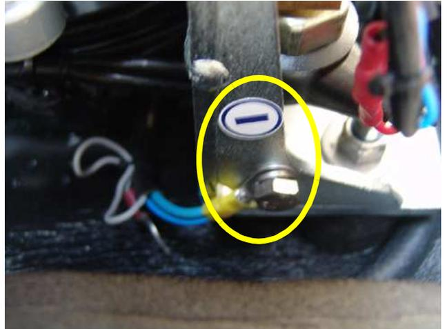
Fig. 3.3.6-3: Conexión del cable negativo de la batería de arranque
