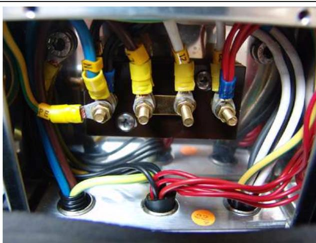
Fig. 3.3.6-14: Caja terminal de potencia del generador de 230 voltios/50 Hz
