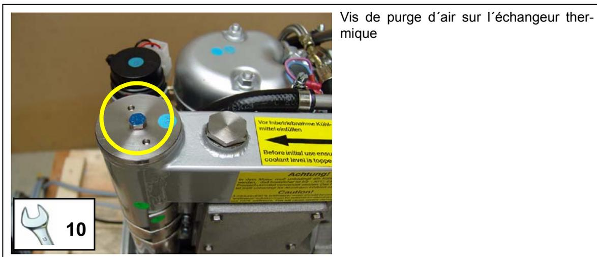
Fig. D.4.3-4: Le purge d'air sur l'échangeur thermique
